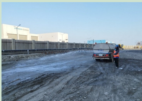
回收水灑水抑制揚塵(台中電廠)
