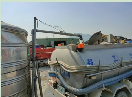
抽取沉沙池裡的水進行工地灑水並達成回收再利用(淡江大橋)
