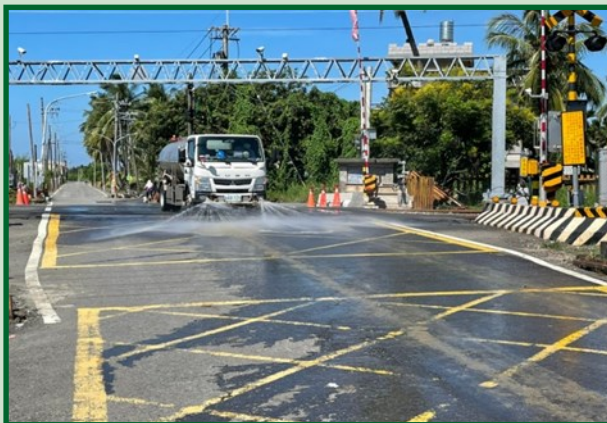
工區車行路徑洗灑水
