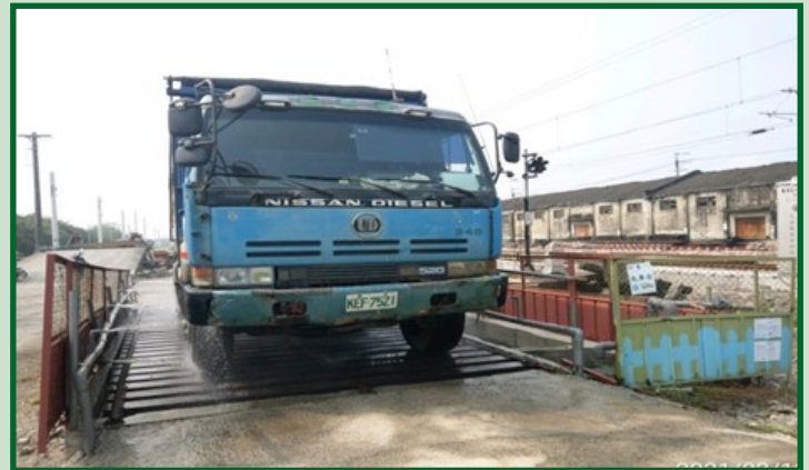
工區洗車台設置
