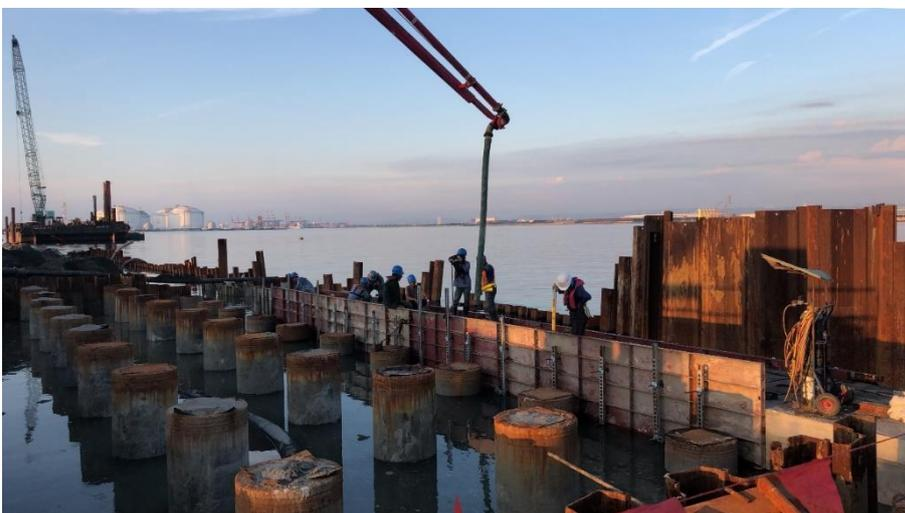
◀圖 24 海側冠牆混凝土澆置作業。
