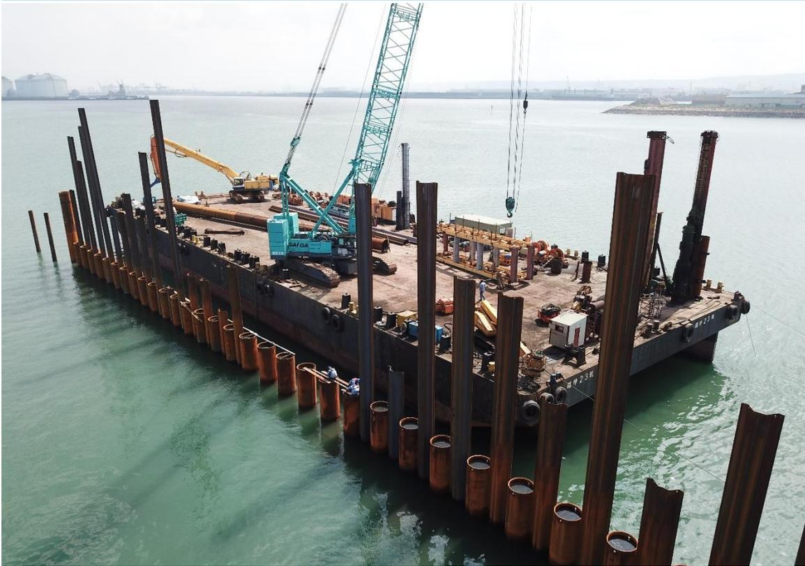
▲圖 9 施工團隊以 11,000T 平台船，及 250T 吊車搭配 12.5T 柴油樁錘進行鋼管板樁打設。
