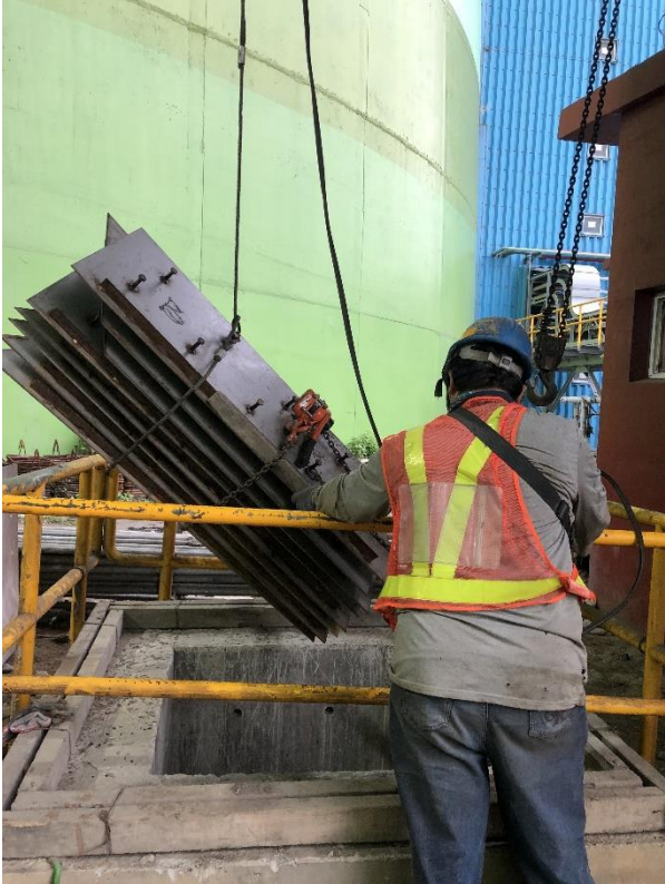
▲ 圖 46 吊裝口，所有材料、機具只能從這個洞口用天車吊裝分批送入（出）內坑。▲
