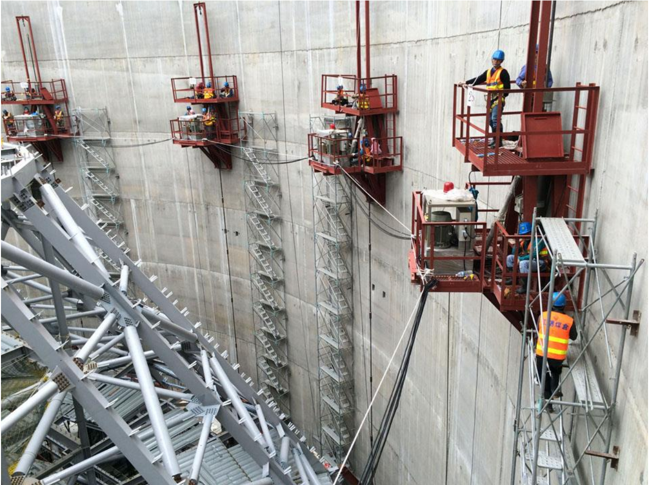
▲ 圖 16 屋頂鋼棒吊裝油壓系統
