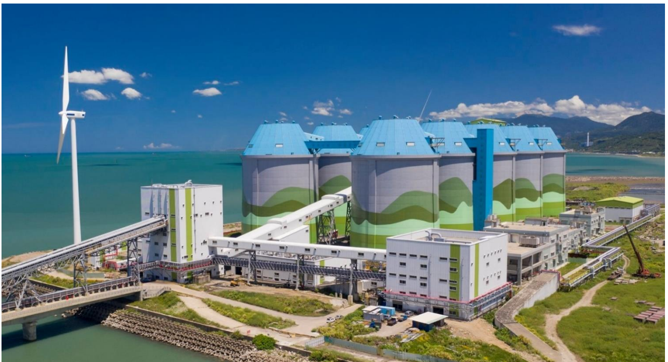
▲ 圖 54 林口電廠筒式煤倉系統
