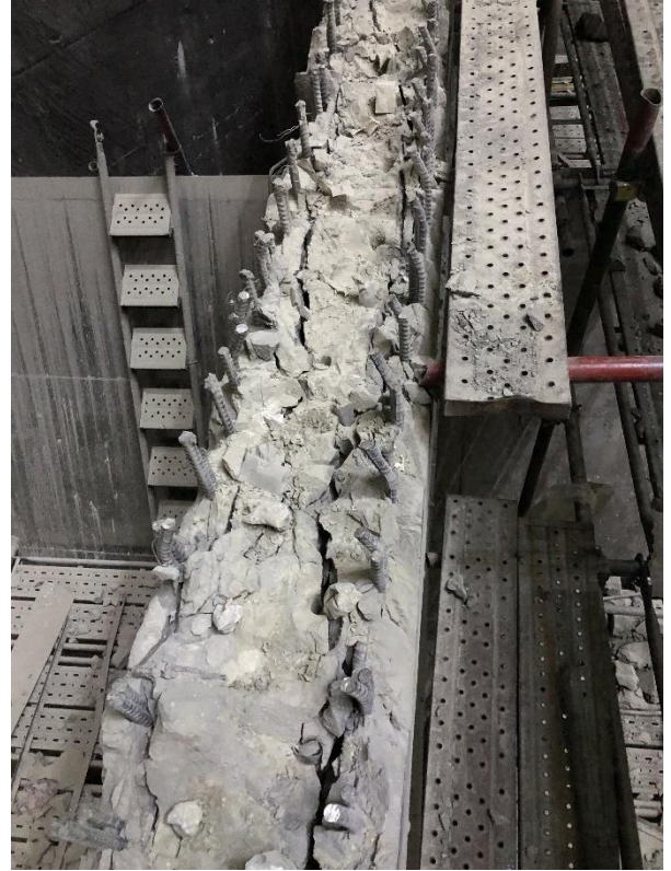
▲ 圖 40 使用無聲破裂劑的效果
