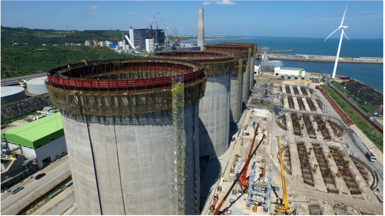
▲ 圖 10 B 列筒倉爬模系統
