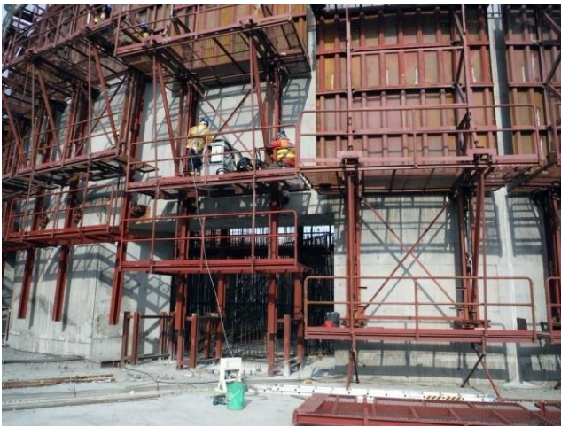
▲ 圖 8 自動爬昇模板系統安裝
