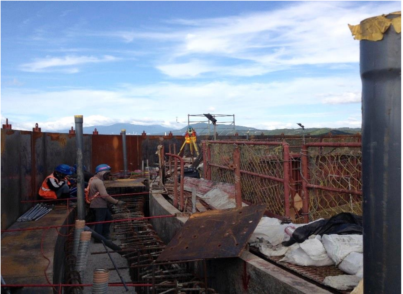
▲ 圖 21 環樑鋼模組立完成後，四周均是鋼模，阻礙風的流動。
