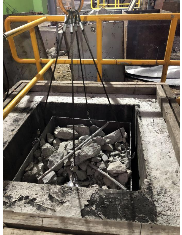
▲ 圖 46 吊裝口，所有材料、機具只能從這個洞口用天車吊裝分批送入（出）內坑。▲
