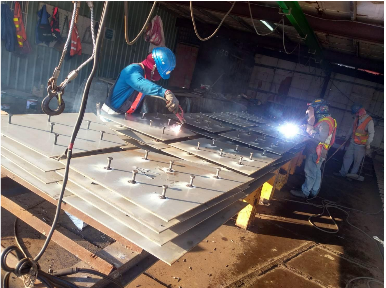
▲ 圖 44 白鐵板加工
