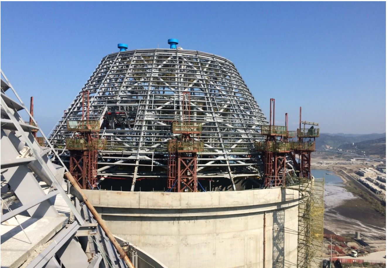
▲ 圖 15 屋頂鋼構第二次提升
