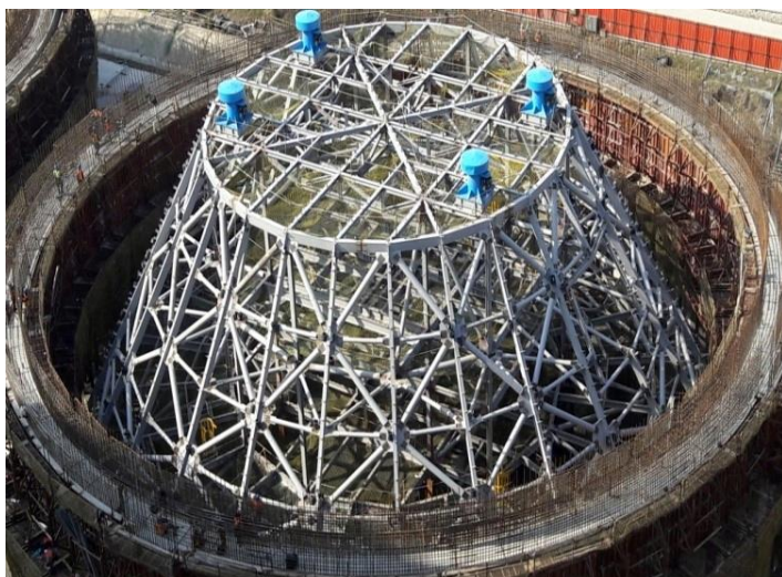
▼ 圖 12 屋頂鋼構地面組立施工 ▶
