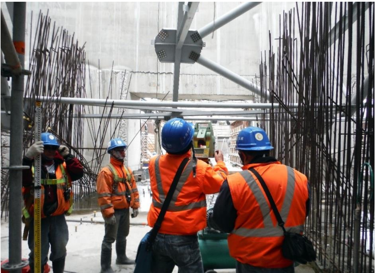
▲ 圖 23 屋頂結構第一階段舉升前，筒倉壁支撐位置高程檢查。
