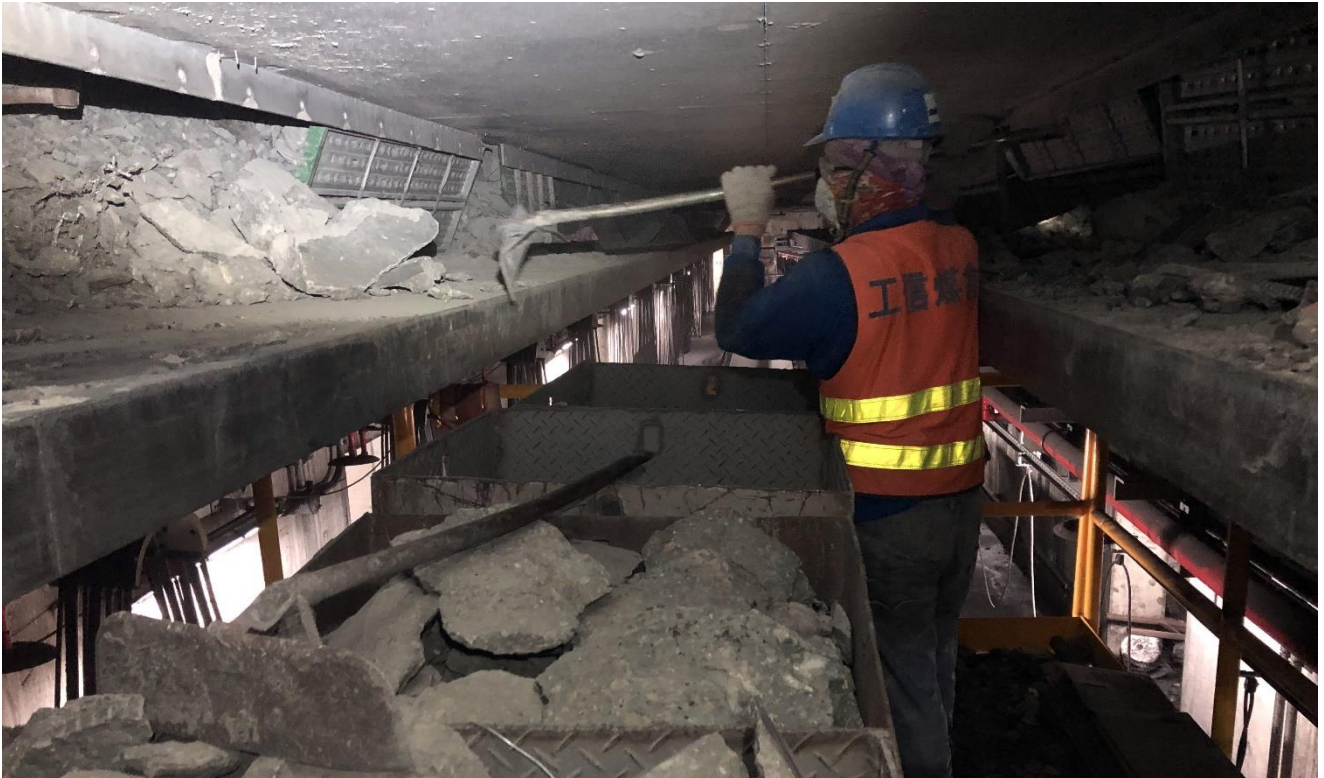
▲ 圖 48 施工人員在台車上清運打除下來的混凝土廢料，而廢料流出來的地方（左上角處），正是平時人員進入修繕點的出入口，得用匍匐的方式橫移進入，從地面層吊裝下來的機具、材料也只能由此洞口傳入。
