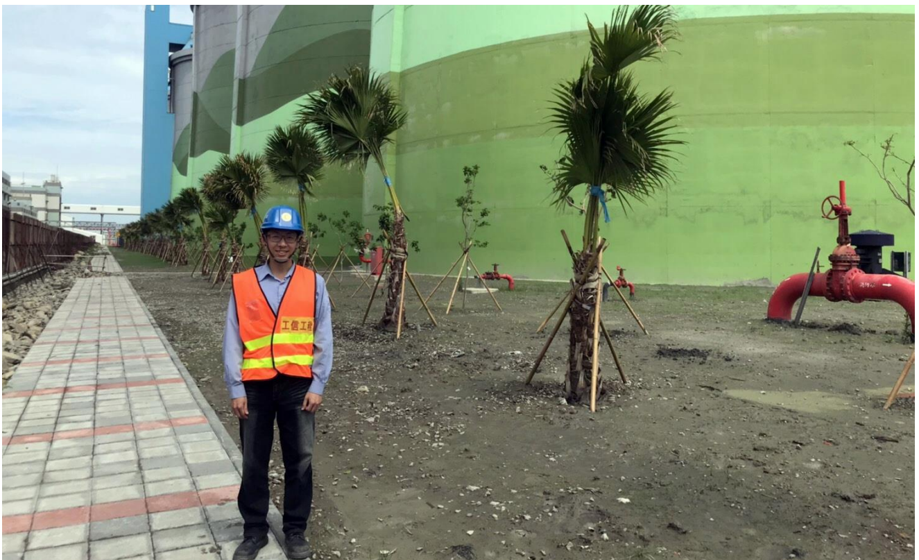
▲ 圖 13 施工組副工程師楊佳竣（阿竣）
