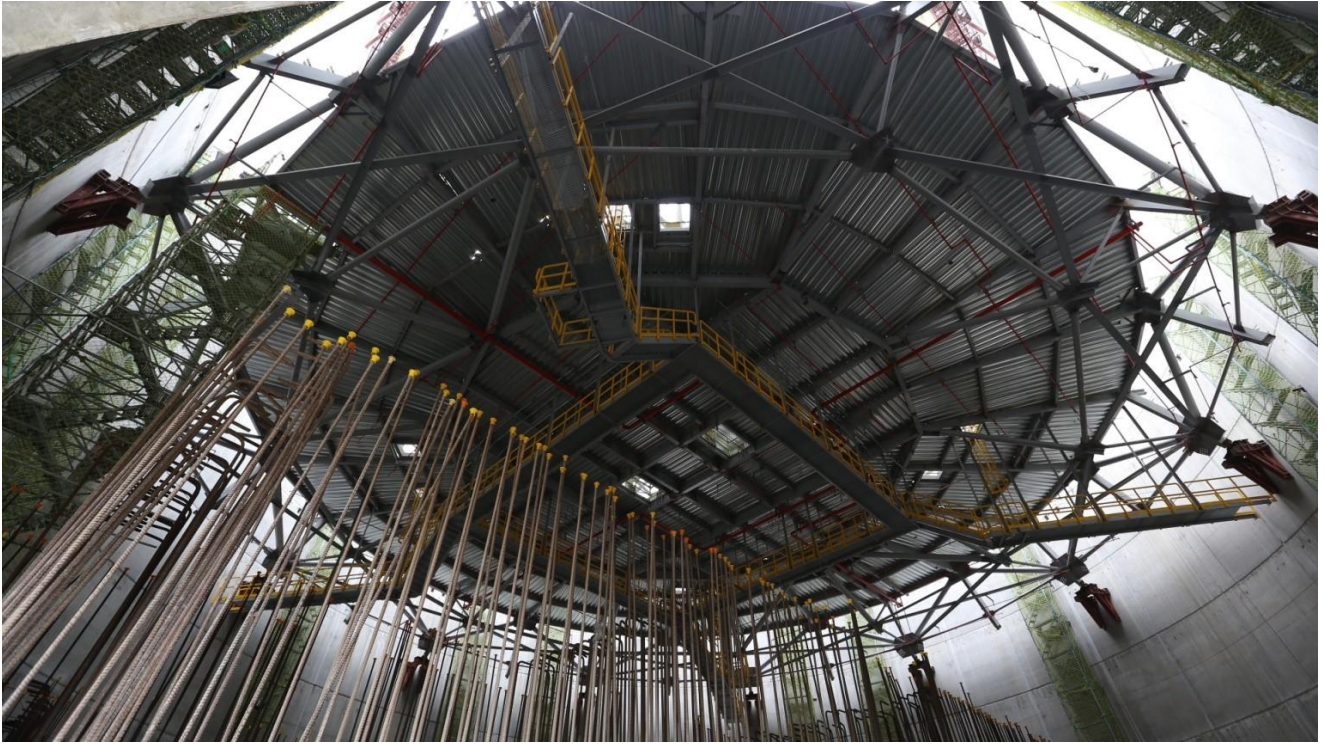
▲ 圖 14 屋頂鋼構第一次提升
