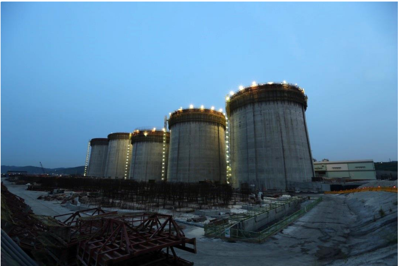
▲ 圖 29 夜間加班照明設備
