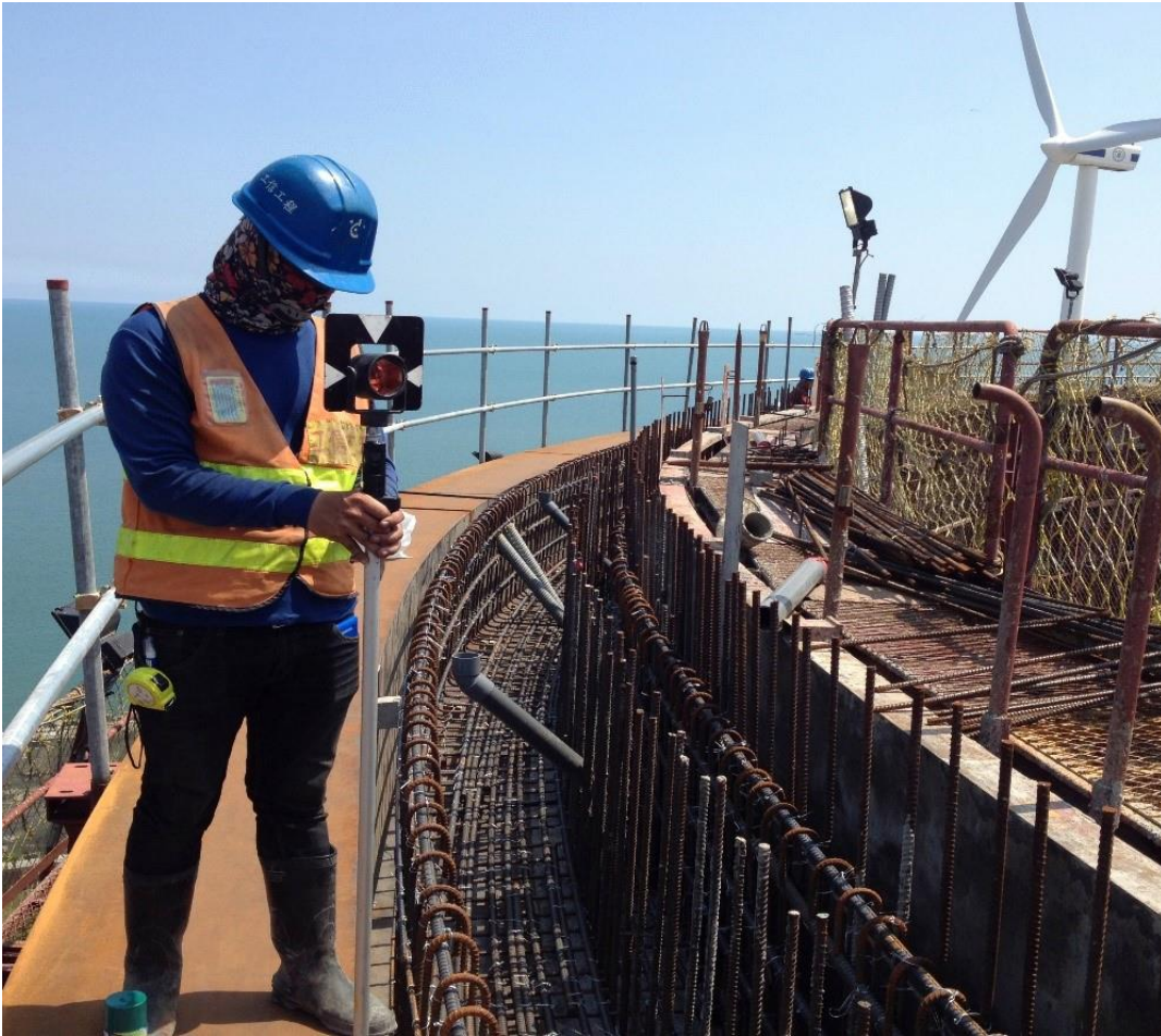
▲ 圖 17 頂層環樑位置及寬度放樣檢測
