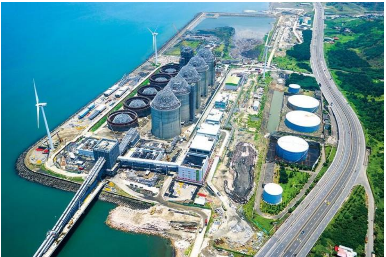
▲ 圖 1 105 年林口煤倉建造施工空拍圖
