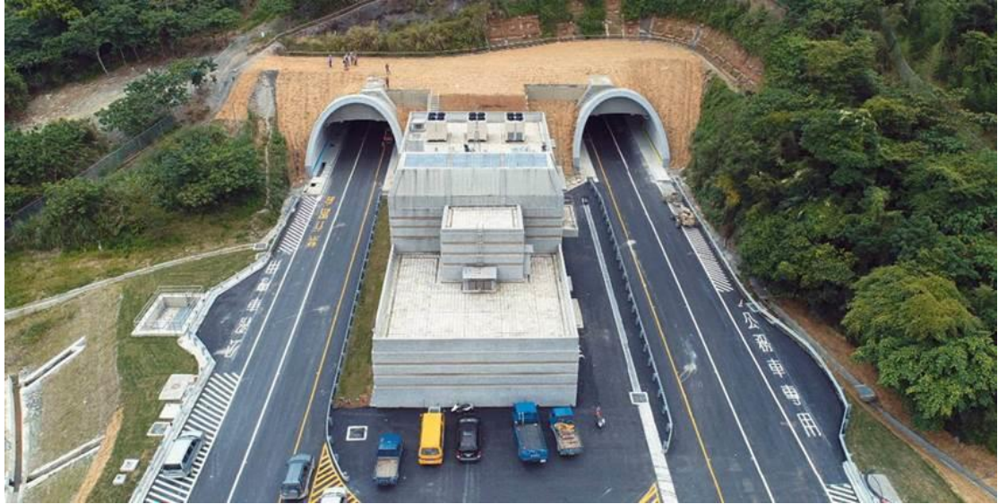
圖 1 B2 標觀音隧道
