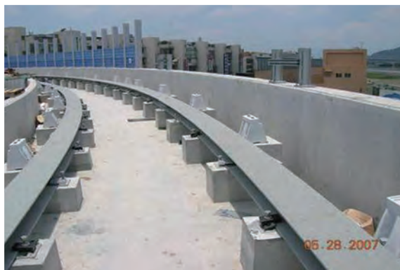
行駛路面基座(固定端)CO2焊接
