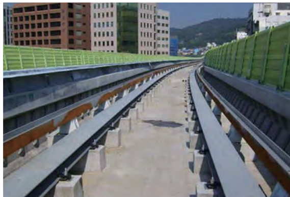
鋼製行駛路面結構及導電軌系統
