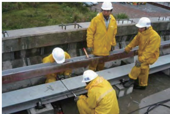
鋼製行駛路面結構-絕緣基座
