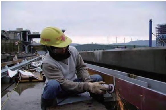
導電軌接合接頭整平
