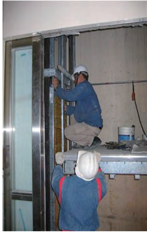
電梯安裝配重塊
