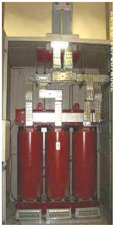
22kv變壓器
