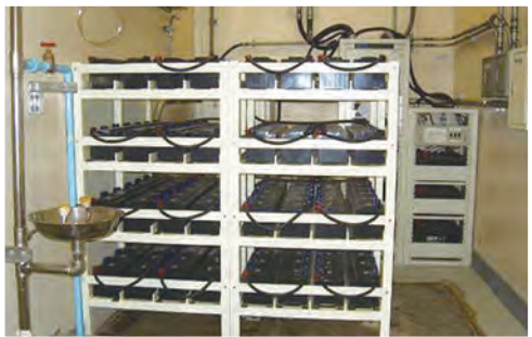
不斷電系統電池室
