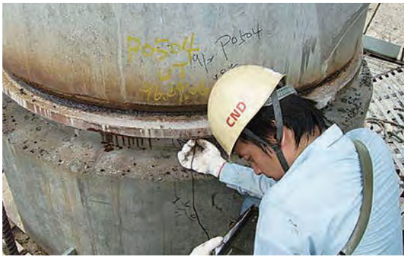
預鑄帽梁連接板銲接UT檢測
