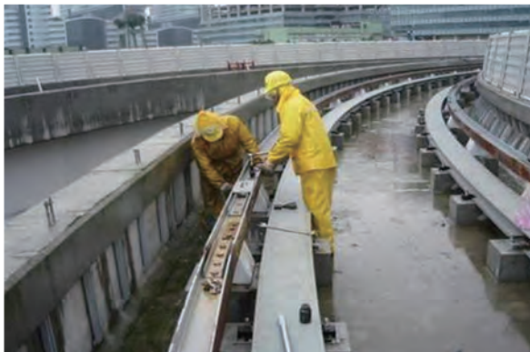
導電軌接合接頭整平
