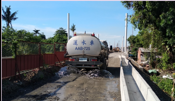
安衛措施-裸露地表灑水抑制揚塵
