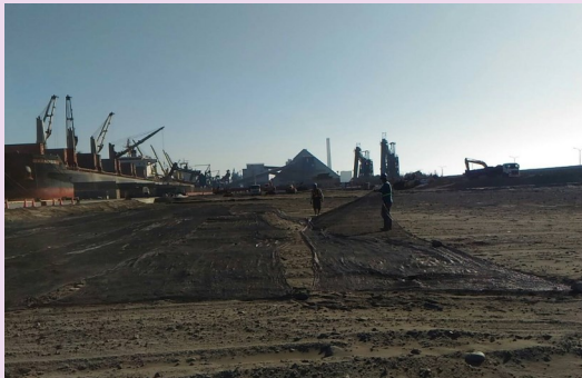
安衛措施-防塵網鋪設
