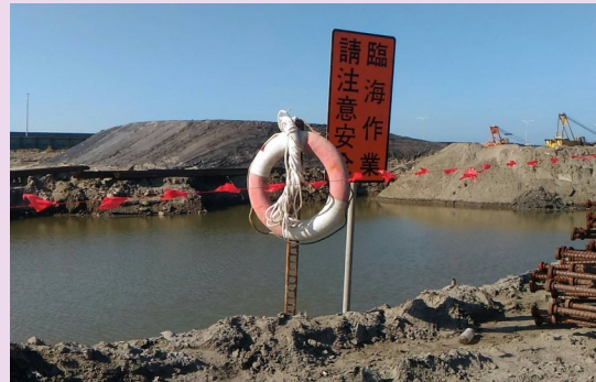
安衛措施-救生圈、警示線佈置
