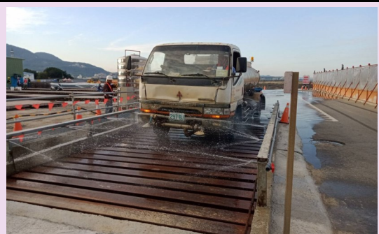
安衛措施-洗車台
