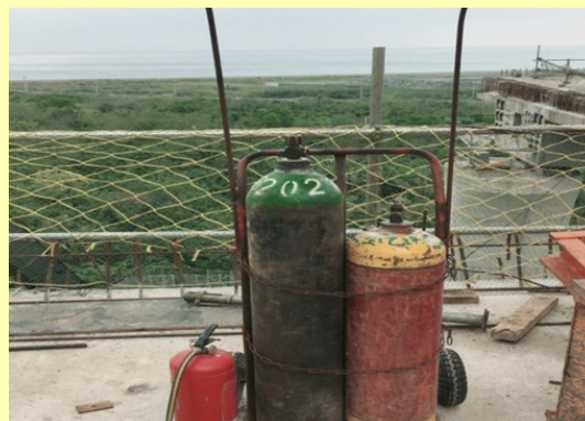
安衛措施-鋼瓶遮陽固定避免發生危險
