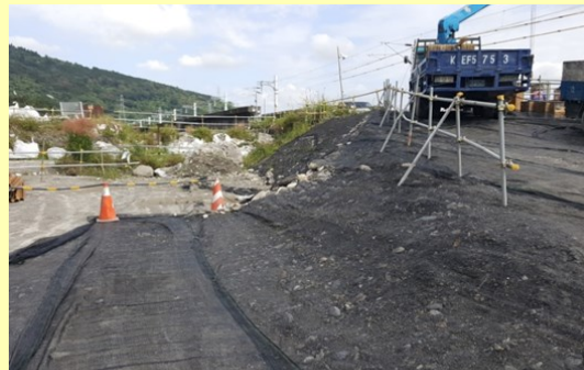
安衛措施-邊坡覆蓋
