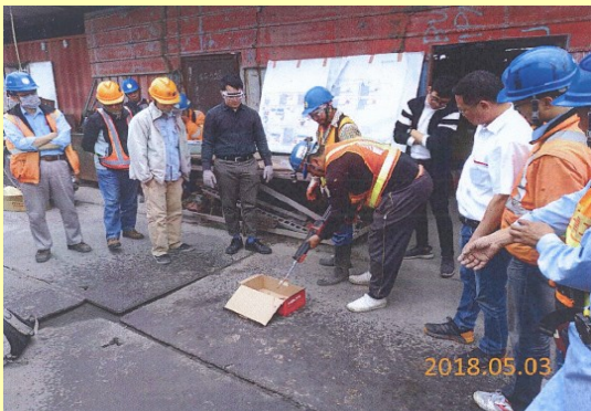
植筋作業安全衛生教育訓練
