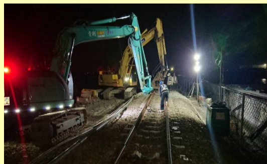
安衛措施-夜間鐵路封鎖施工
