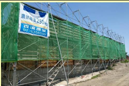
安衛措施-CNS4750 施工架設置
