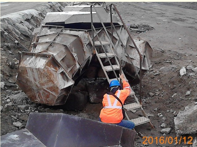
設置上下設備
