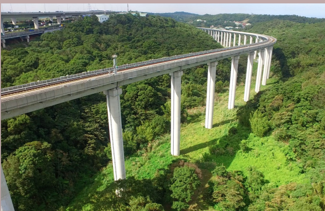
機場捷運 CE02 標高架橋梁
