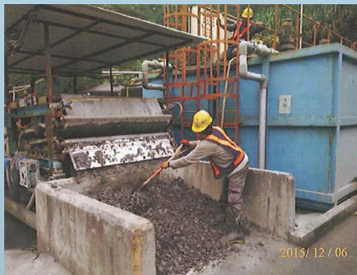
觀音隧道工程污水處理設備
