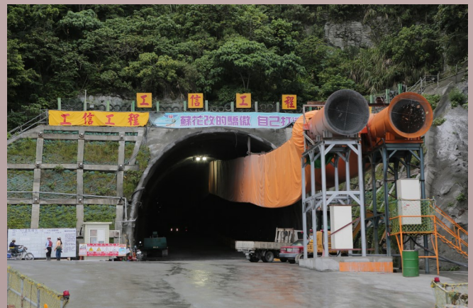
台九線蘇花公路改善工程谷風隧道
