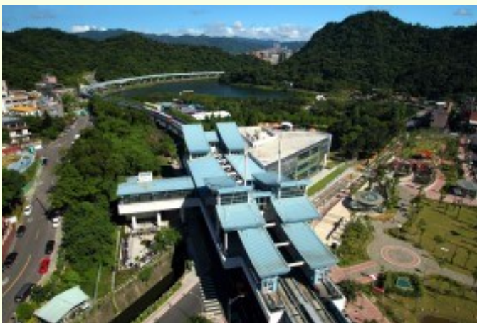
台北捷運文湖線CB410區段標大湖公園站
