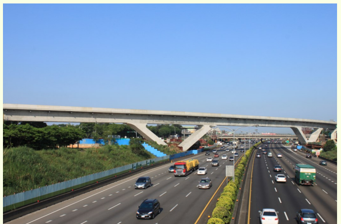
機場捷運CE02標V型橋
