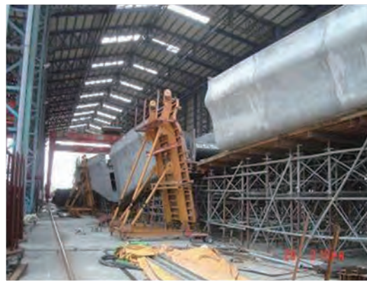
U箱型樑節塊施作
