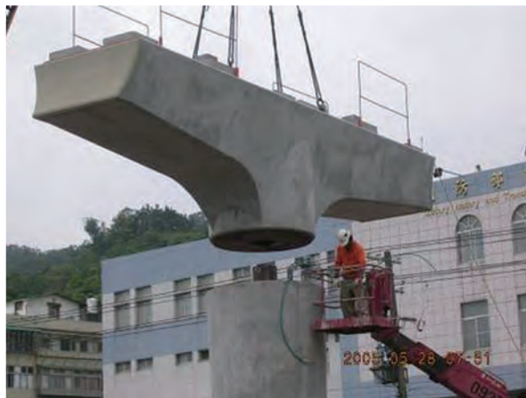
預鑄帽梁吊裝
