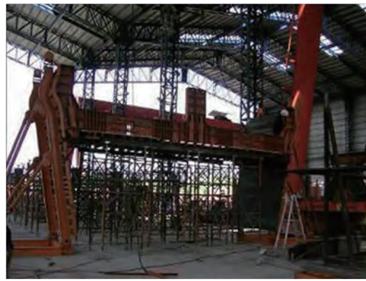
端部節塊鋼模組立
