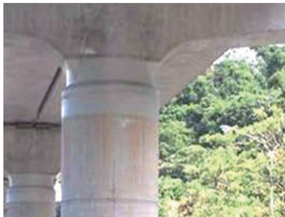
銲接接合處塗佈環氧樹脂砂漿
