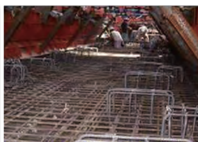
行駛路面及導電軌基鋼筋預埋施作
