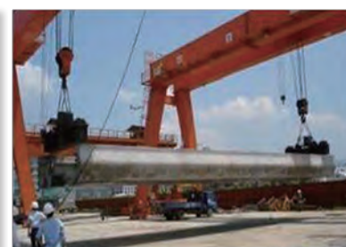
U型樑吊離
