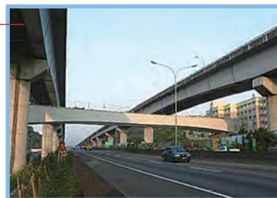
穿越高速公路鋼橋吊裝作業完成
