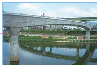
基隆河段場鑄懸臂節塊完成
