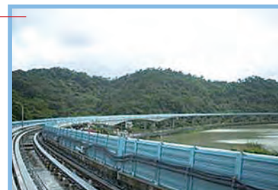
高架段軌道工程全線施作完成
