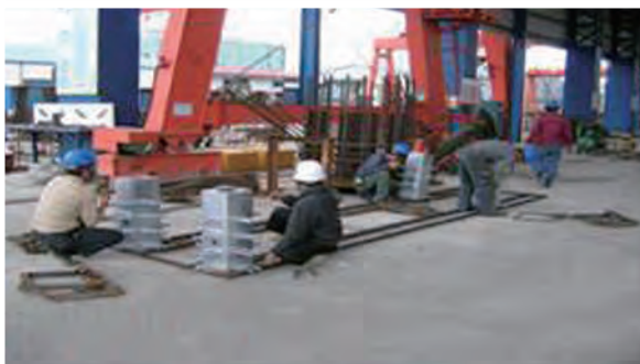
帽梁鋼筋籠組立完成
